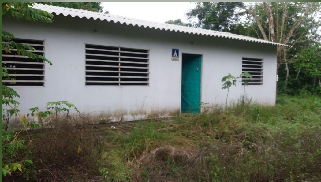
Foto Predio San Ignacio. Infraestructura sin uso.
