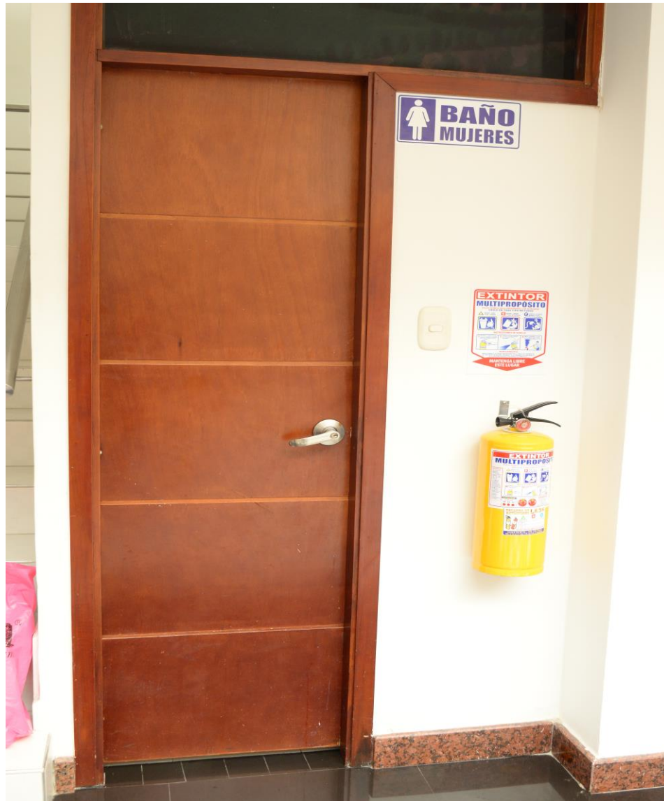
FOTO N°53 BAÑO SEGUNDO PISO
