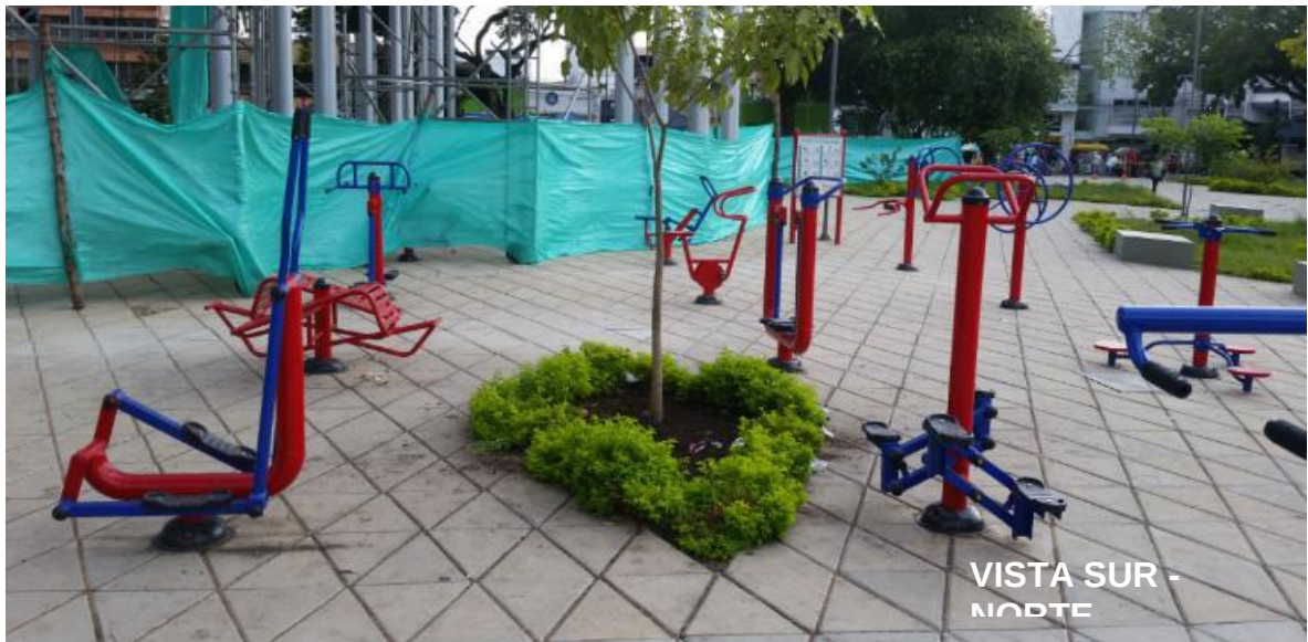
FOTO: No 37 CONSTRUCCIÓN DE OBRAS DE REMODELACIÓN
