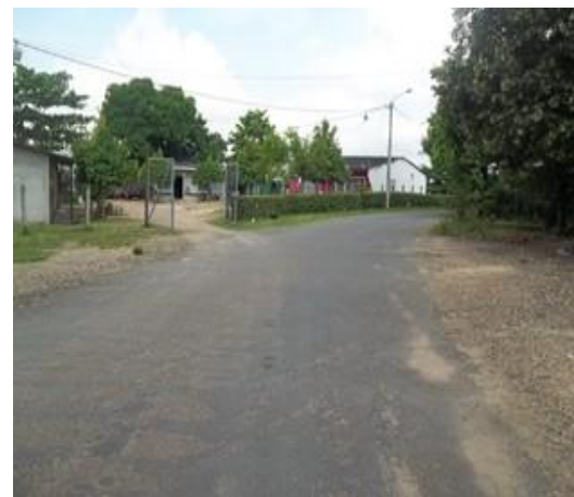
FOTO NO 21 tramo final de obra ejecutada
