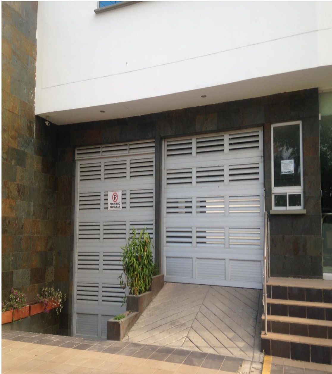
FOTO N°41 ENTRADA AL PARQUEADERO Y SÓTANO EDIFICIO INTELIGENTE Calle 71 No 27.08
