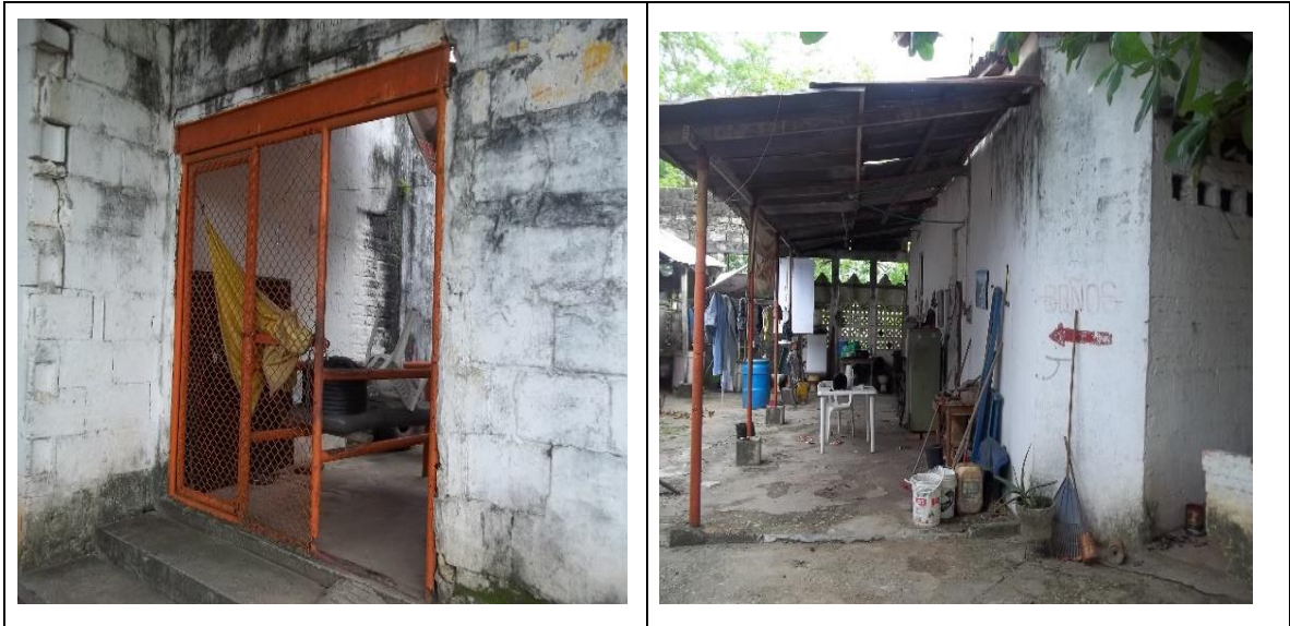
FOTO N°77 VISTA GENERAL DEL SECTOR DE BODEGA DE ALMACENAMIENTO
