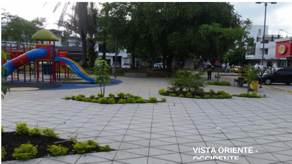
FOTO: No 38 CONSTRUCCIÓN DE ADECUACIÓN URBANISTICA
