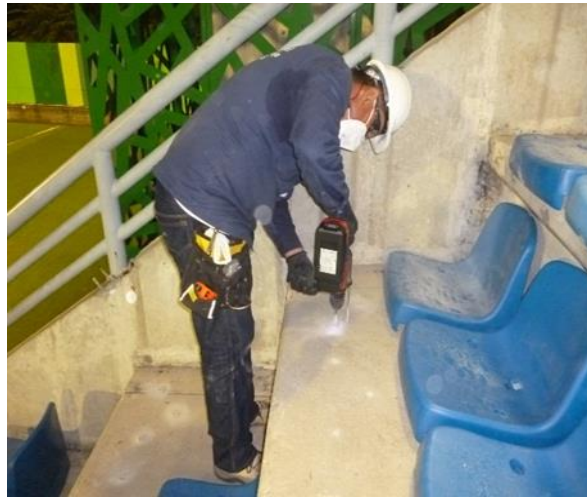
FOTO No 5. ANCLAJES CON CHAZOS DE EXPANSION METALICOS
