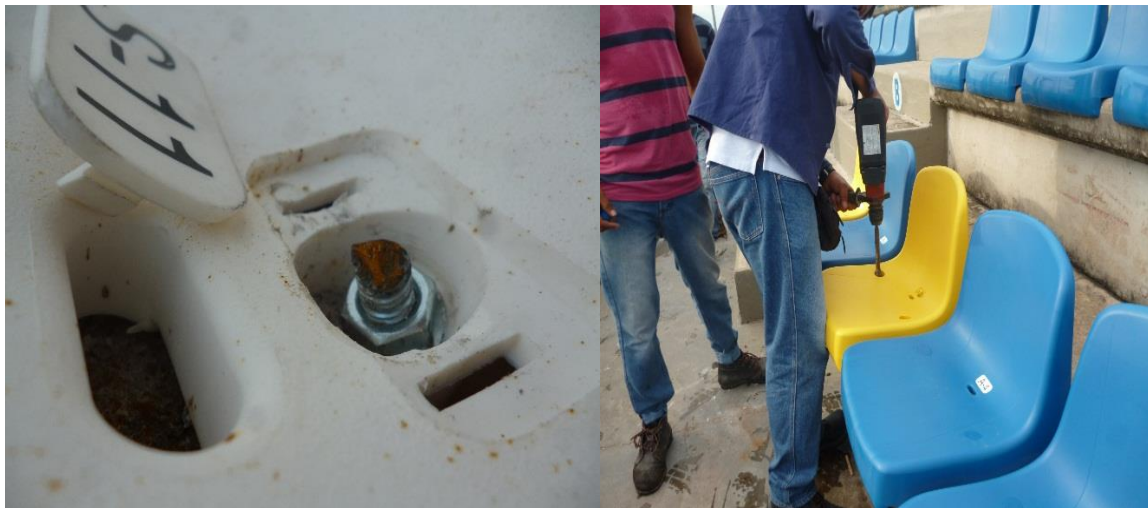
FOTO No 6. VISTA GENERAL DE ANCLAJES DE SILLETERIA
