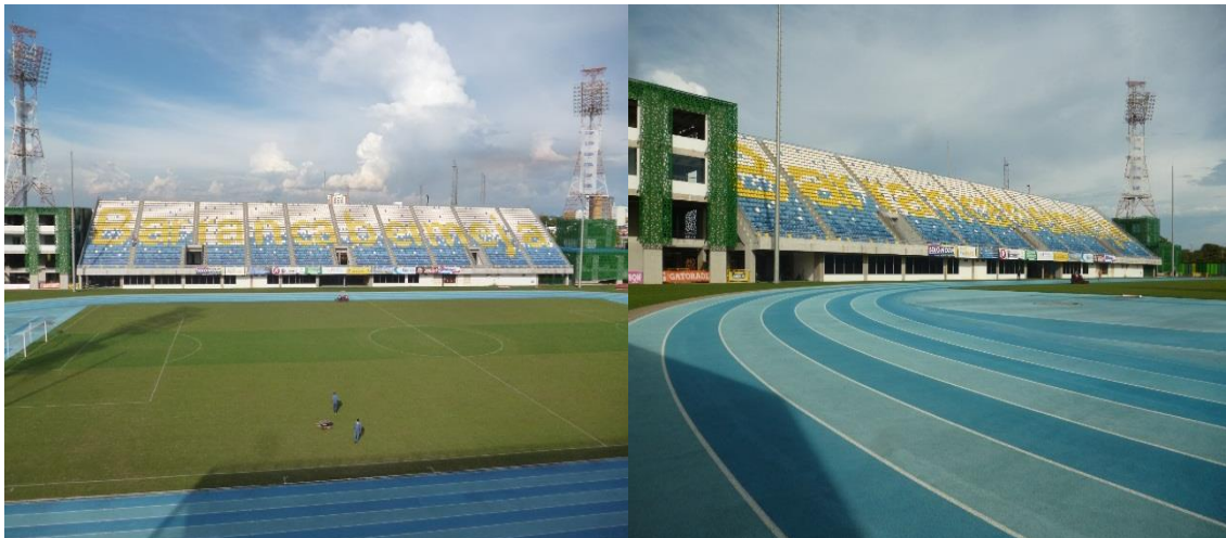
FOTO No 8. VISTA GENERAL DE LAS TRIBUNAS TERMINADAS
